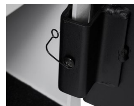
Entgegenkommend: sanfte Auto-Open-Funktion mit Springfeder
